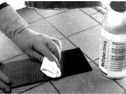
Abb. 13: Chemisches Nachbehandeln einer vorgeschliffenen Oberfläche
